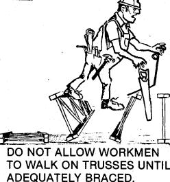
5 ERECTION BRACING
