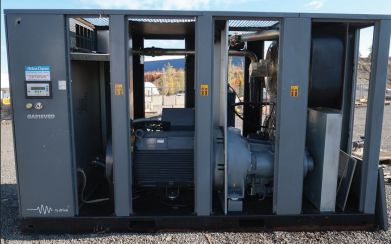
ATLAS COPCO GA315VSD
